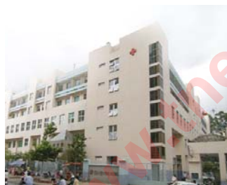
Hung Vuong Hospital, HCMC 5 Bed lifts 1000-1300kg, 1.0 m/s
